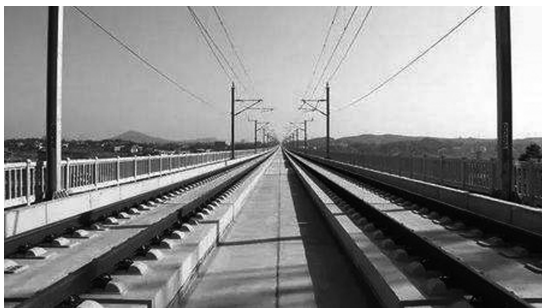
图 1-5 混凝土整体道床
