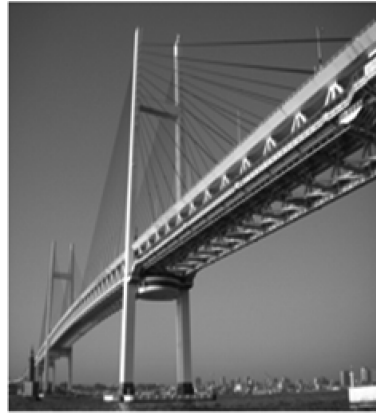
图 1-2 道路与桥梁工程
