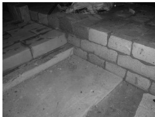
图1-9 高温区炉底结构
