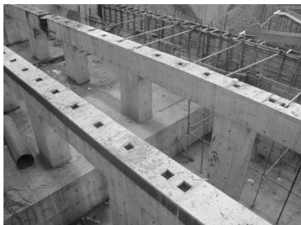
图 1-11 加热炉基础
