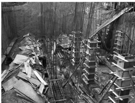
图 1-1 柱下钢筋混凝土条形基础施工现场
