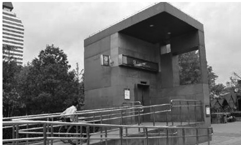
图 1-13 地铁车站直升电梯
