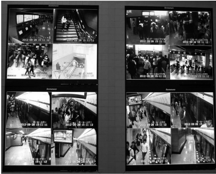
图 1-39 闭路电视监视系统画面
