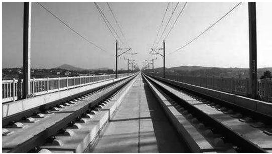
图 1-5 混凝土整体道床
