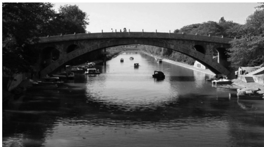
图 1-13 河北赵县安济桥
