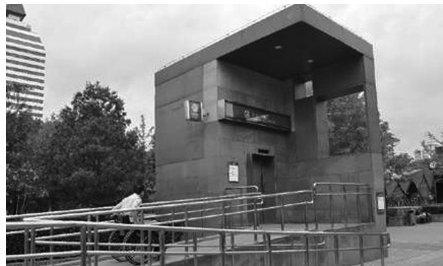
图 1-13 地铁车站直升电梯
