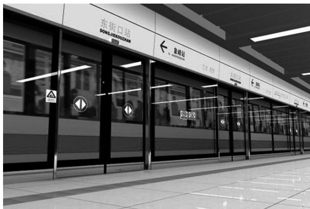
图 1-16 全高封闭式站台门
