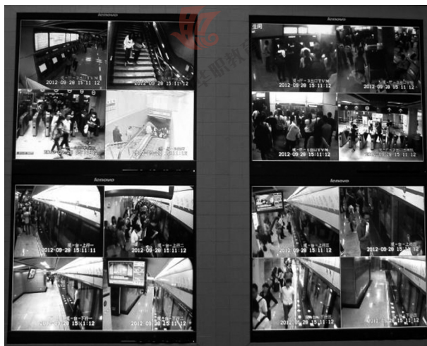
图 1-40 闭路电视监视系统画面
