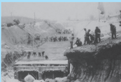
图1-9 明挖回埋法施工
